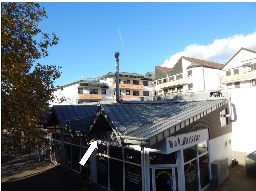
Abb. 3: Das Gebäude „Parkplatz“ bietet (fast) keine Einschlupf- oder Hangmöglichkeiten. Im Dachbereich findet sich aber ein Nest, vermutlich einer Taube (Foto: 08.11.2018).
