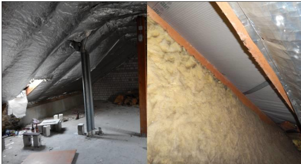
Abb. 5: Dieser Dachbereich mit Dämmmaterial ist wie die übrigen durch Folie nach außen abgedichtet und bietet (fast) keine Einschlufl- und Hangmöglichkeiten für Fledermäuse (Foto: 08.11.2018).
