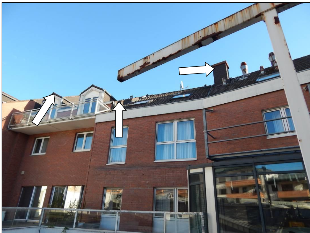
Abb. 6: Der Gebäudekomplex bietet vereinzelt Einschlufl- und Hangmöglichkeiten für Fledermäuse als Sommerquartier im Dachbereich (Foto: 08.11.2018).
